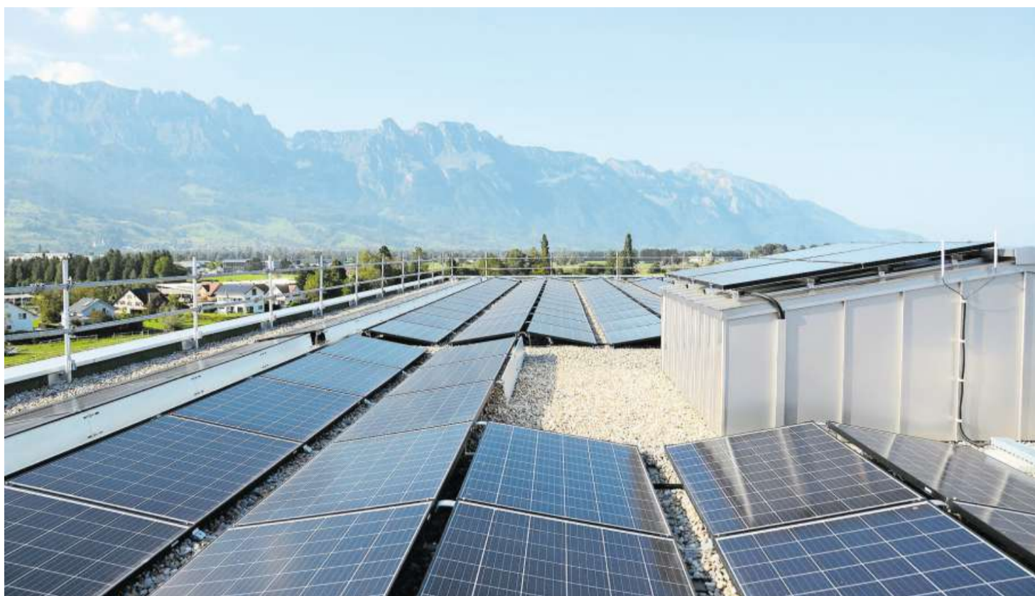
Knapp 600 Photovoltaikmodule sind allein auf dem Dach installiert.
